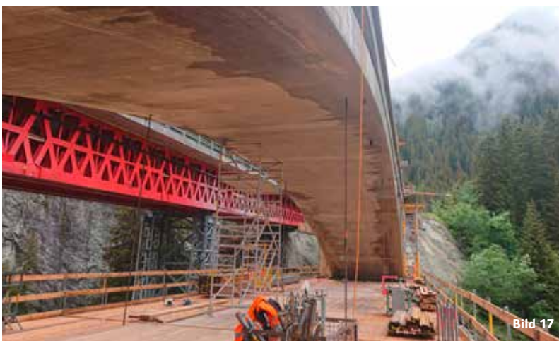
Zustandserfassung an einer Stahlbetonbrücke
