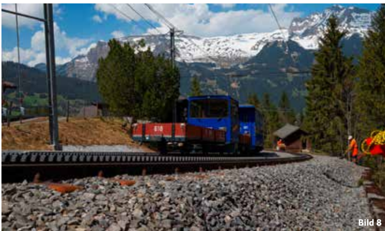
Erfassung des Streustromgefährdungsradius einer Gleichstrombahn
