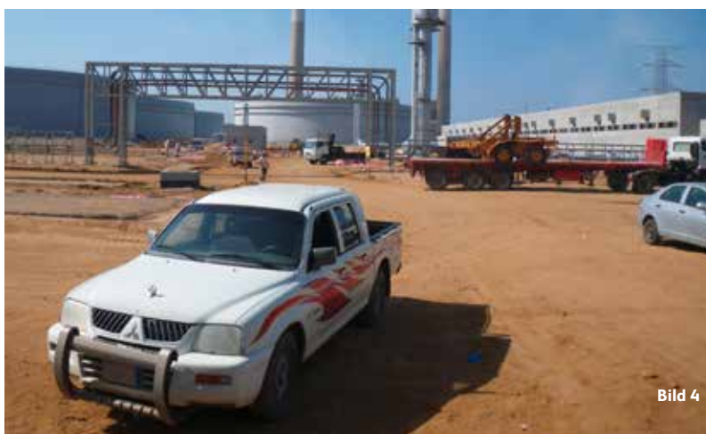
Untersuchungen in einem Pumpwerk in Saudi-Arabien
