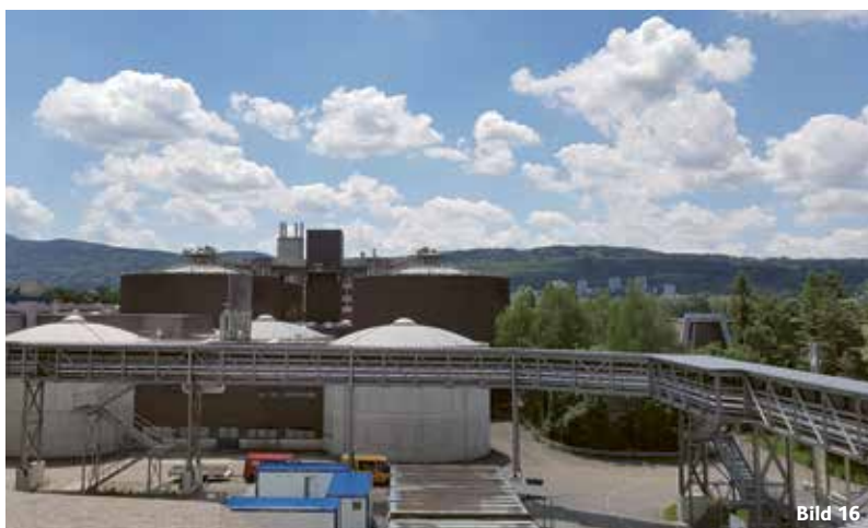
Kontrolle des Korrosionsschutzes in einer Kläranlage
