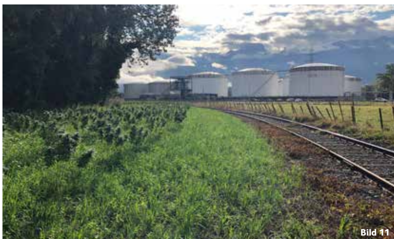
Korrosionsuntersuchungen in einer Tankanlage
