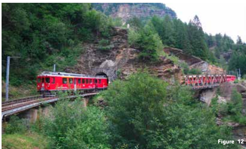
Mesures du courant vagabond sur la ligne de la Bernina
