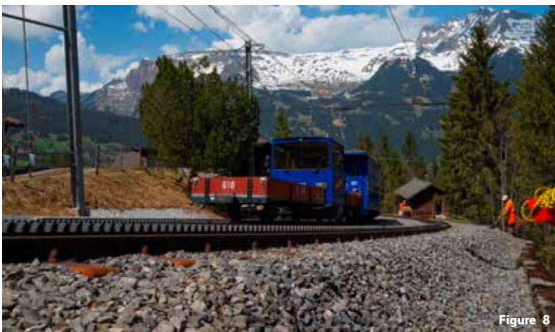
Détection du rayon de danger de courant vagabond d'une piste en courant continu
