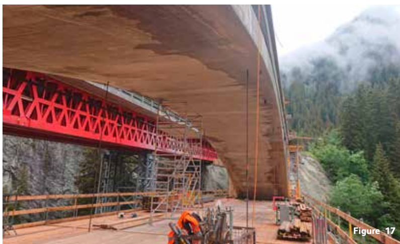
Relevé d'état sur un pont en béton armé
